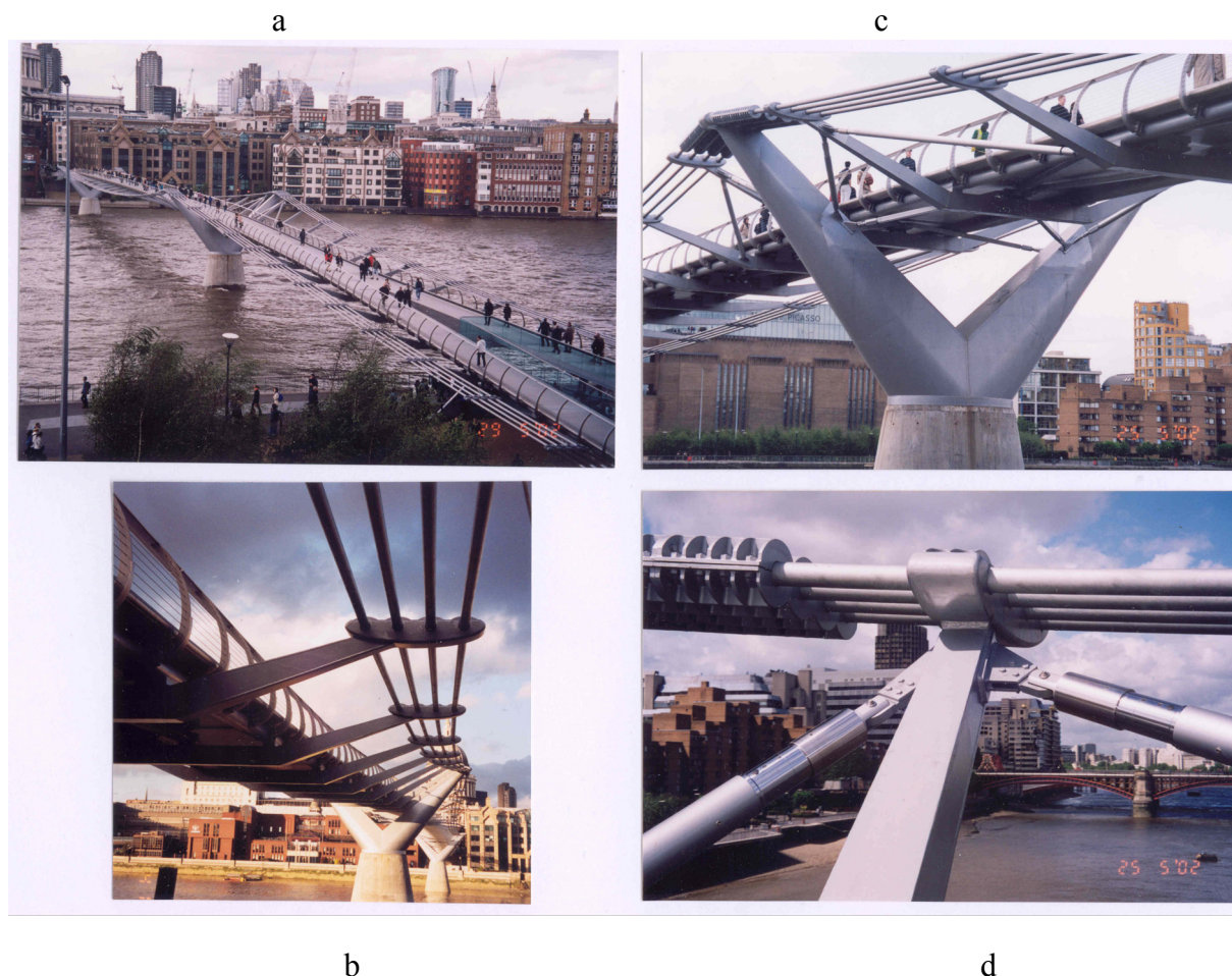
Obr. 2: Pěší most „tisíciletí“; a – celkový pohled, b – původní uchycení příčníků na lanech, c, d – uchycení příčníků s hydraulickými tlumiči po rekonstrukci
