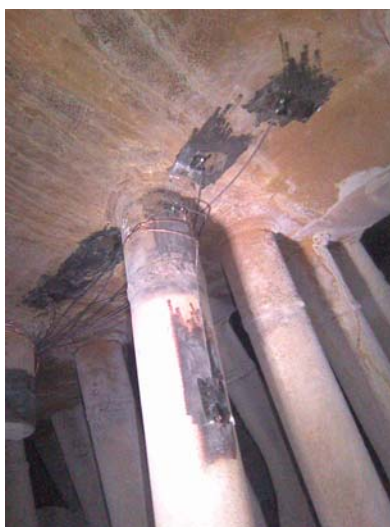
Obr. 4 Osazený nátrubek č. 7, pohled k průřezu
