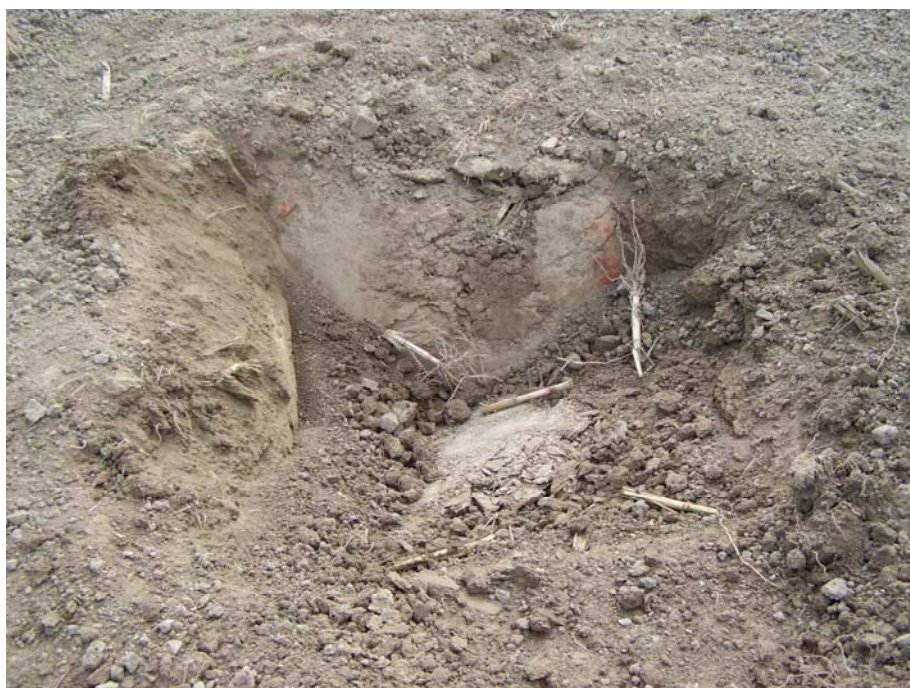
Obr. 4: Odpovídající deformace povrchu
